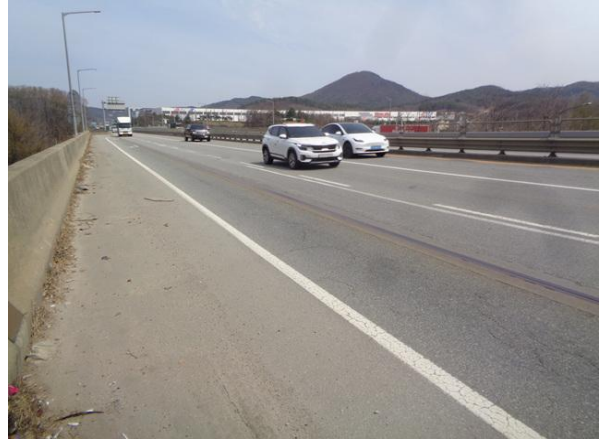
교량 상부 전경
