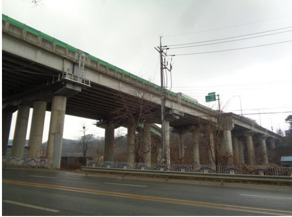
교량 측면 전경
